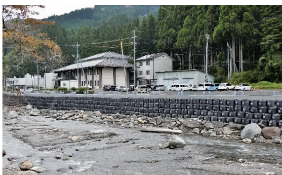
佐治川上流 護岸補修状況
