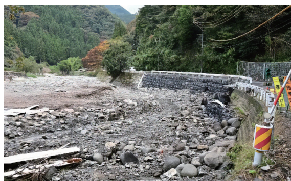
佐治川ダム下流 護岸一方通行地点
