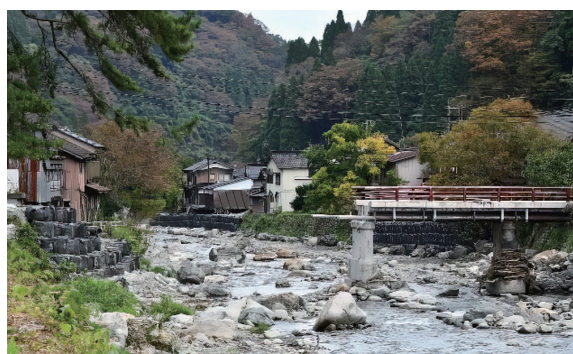
佐治町中心部 橋の崩落1
