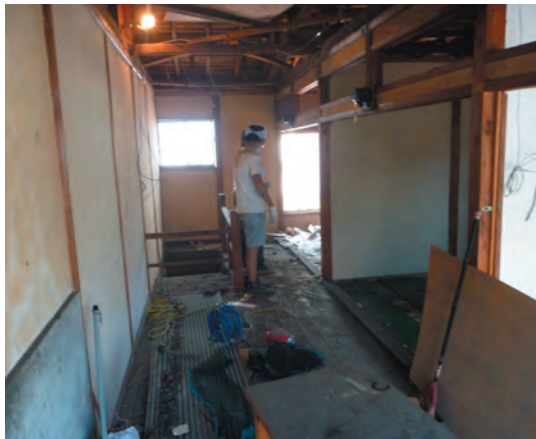
2F 廊下工事前
