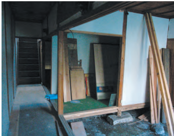
1F 共有スペース工事前
