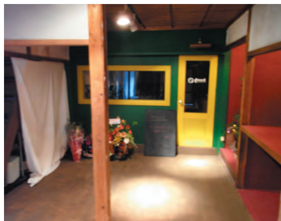
1F 店舗工事後
