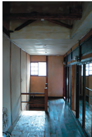
2F 廊下工事後
