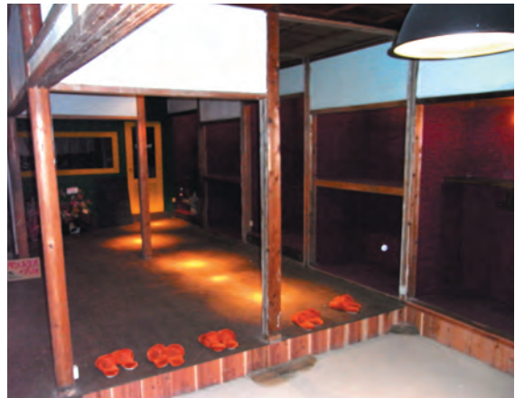
1F 共有スペース工事後
