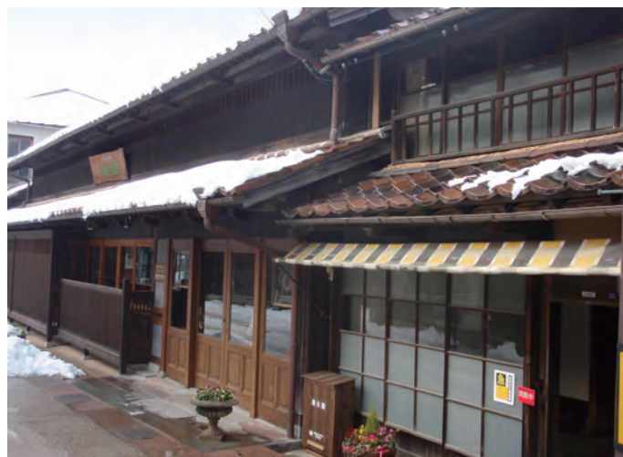
改修した空き家（手前）と伝統的建築の店舗（奥）
