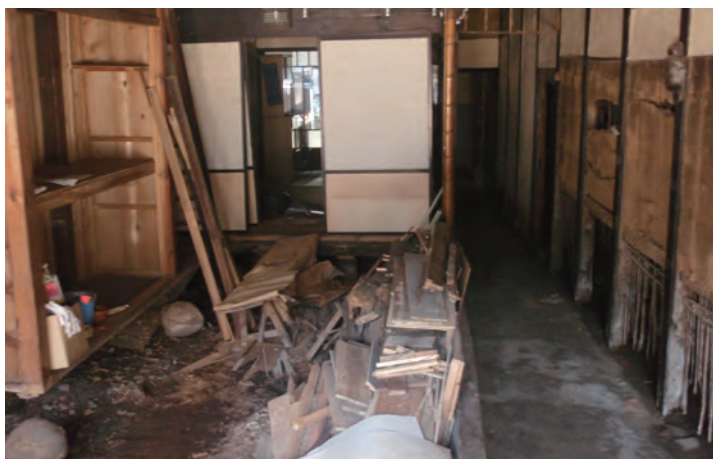
改修工事中の空き家
