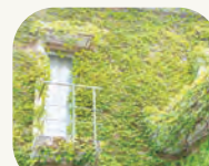
グリーンウォール 建築物の外側に植物を生育さ せ温度上昇抑制を図ります。
