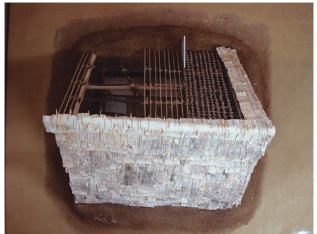
図25 模型制作プロセス⑥ 樹皮葺
