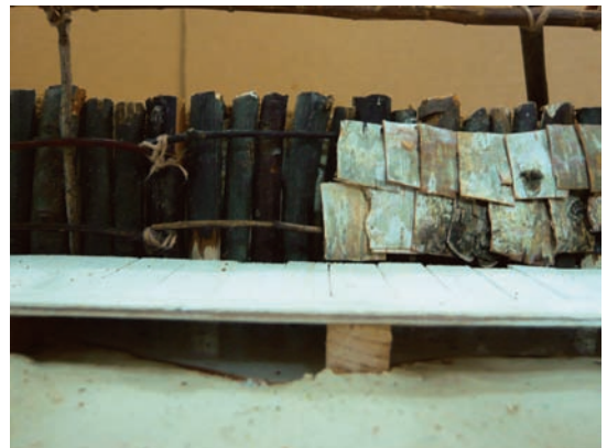
図13 板壁の構造
