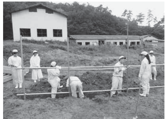
写真4 放牧柵の設置
