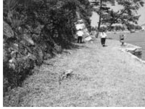
図2 石垣下の犬走り
